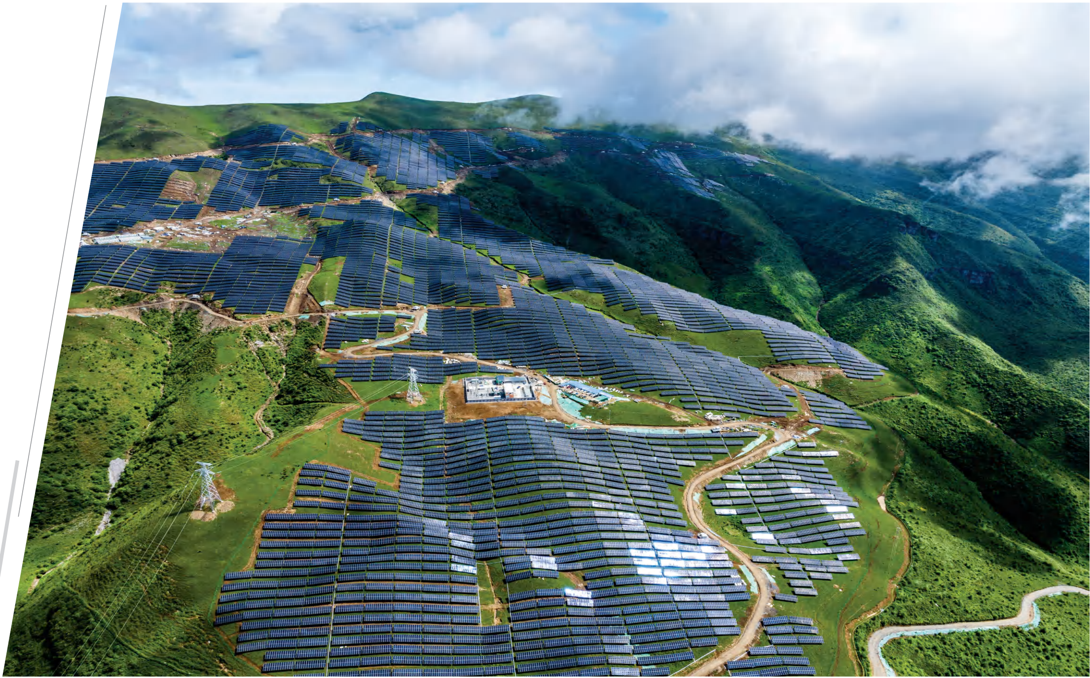
2024年，四川新质生产力加速发展，全省发展的“含绿量”“含金量”“含新量”稳步提升。图为建设中的四川水光互补发电项目。
