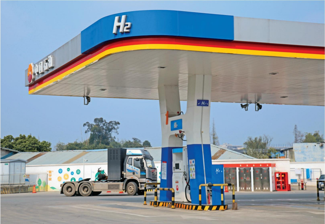
加氢站在氢走廊建设中至关重要。图为一辆氢燃料电池车正驶入郫都区中国石油古城加油加氢站。
