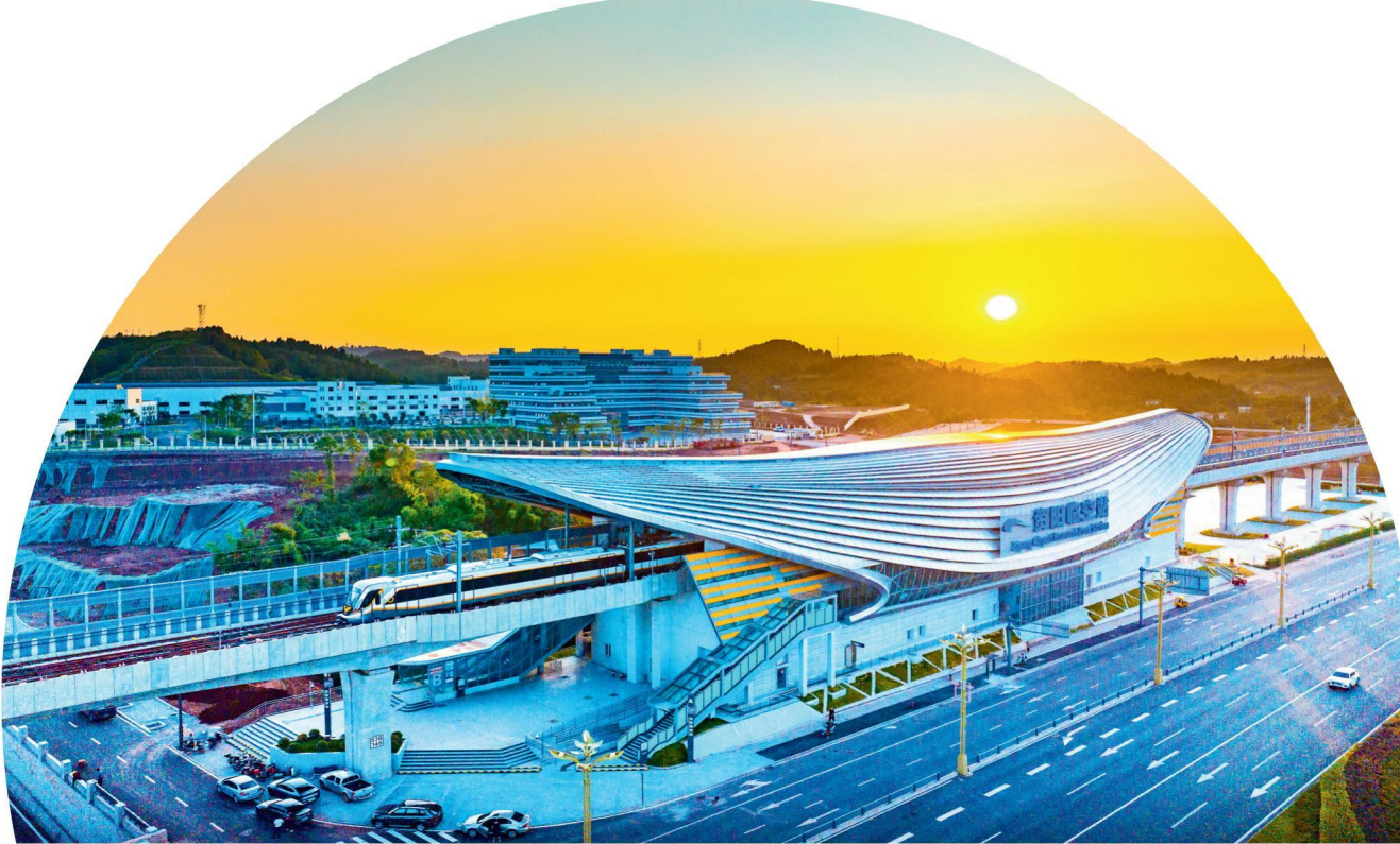
资阳的发展和交通息息相关。图为成都地铁S3号线资阳临空站。
